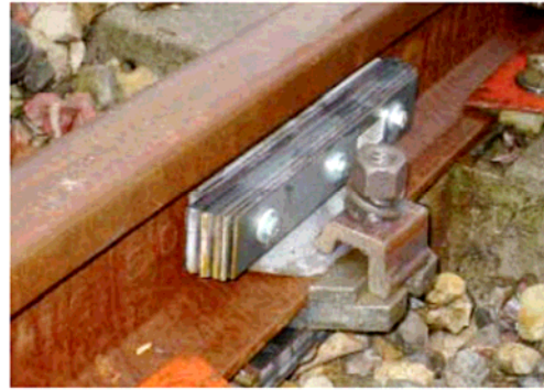
Exemples d'absorbeurs sur rail (Corus et Socitec)
