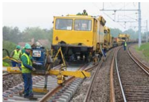
Longs Rails soudés sur traverses béton
